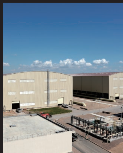
Завод по опреснению морской воды, Алжир
