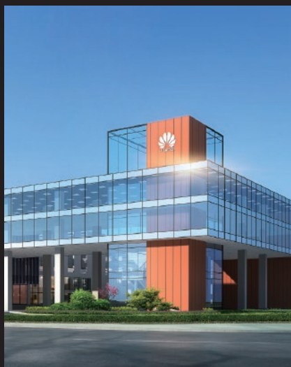
Центр облачных вычислений Huawei, Китая
