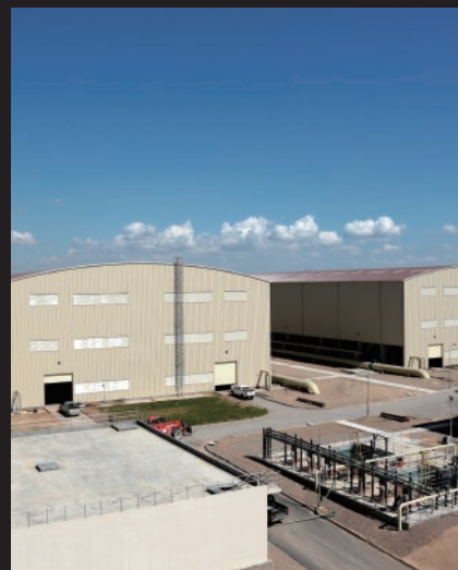
Завод по опреснению морской воды, Алжир
