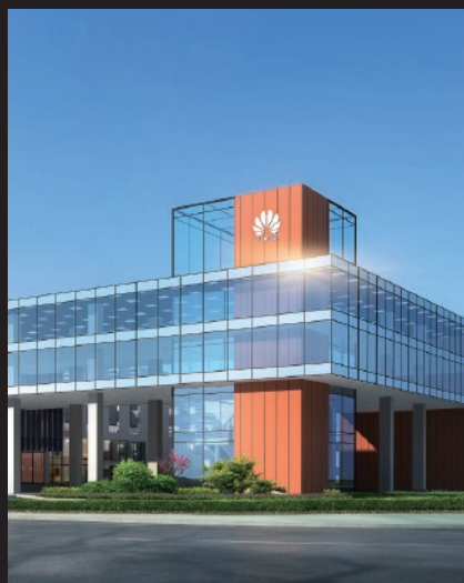
Центр облачных вычислений Huawei, Китая
